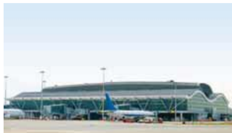
玻璃幕牆工程 — 香港國際機場北衛星候機大樓
