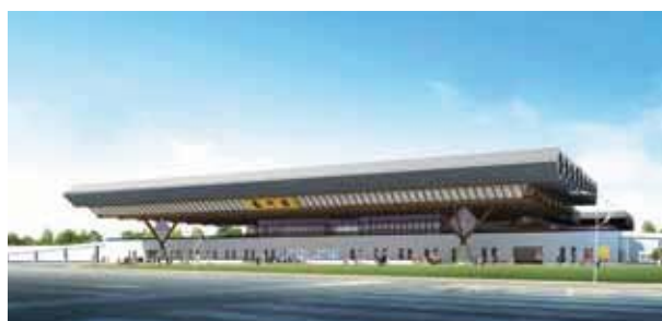
玻璃幕牆工程 — 中國高速鐵路蘇州站
